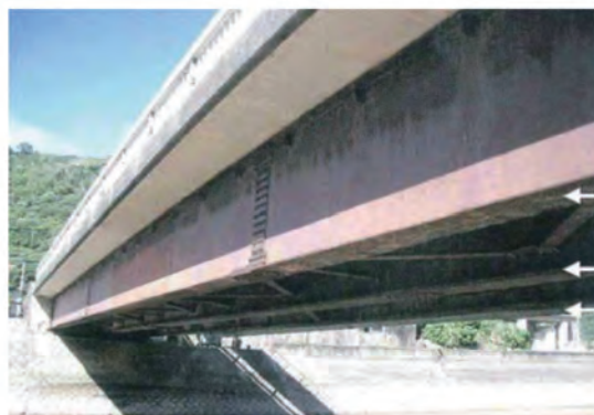
图 27 腐蚀劣化的日本耐候钢桥
