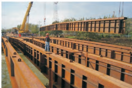
图20 钢梁整体吊装
