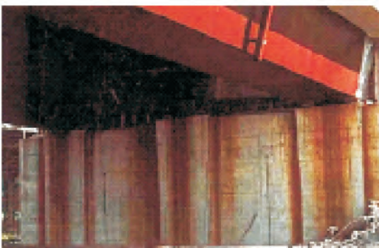
图 24 未形成稳定锈层导致锈液流淌到墩台上
