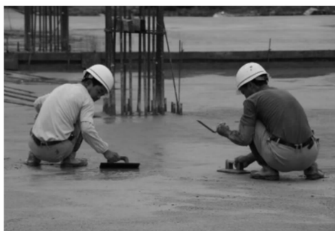
图 31 混凝土表面抹平
